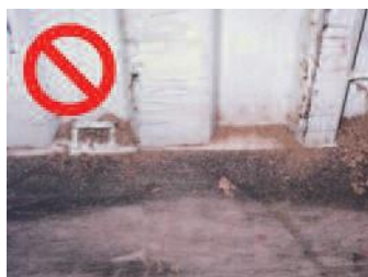
Støv og lastrester
